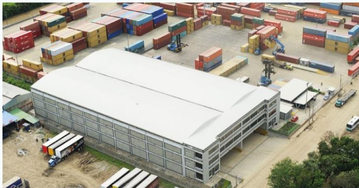
Bodega y Patio Contenedores Yumbo
